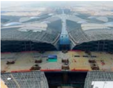
北京新机场航站楼前高架合龙
